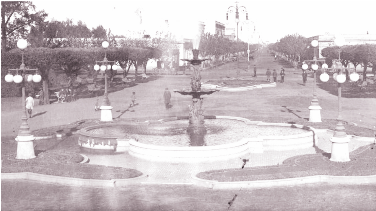
La fuente ornamental, en una fotografía tomada poco después de su instalación.
